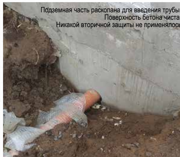
Смонтирован гидроизоляционный жгут «Пенебар»
