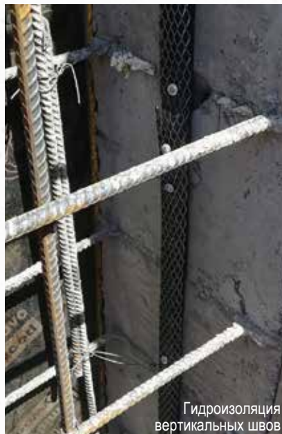
Бетонирование стен с «Пенетрон Адмикс»
