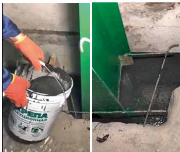
Рис. 6. Заливка растворной смеси «Скрепа М600 Инъекционная»
