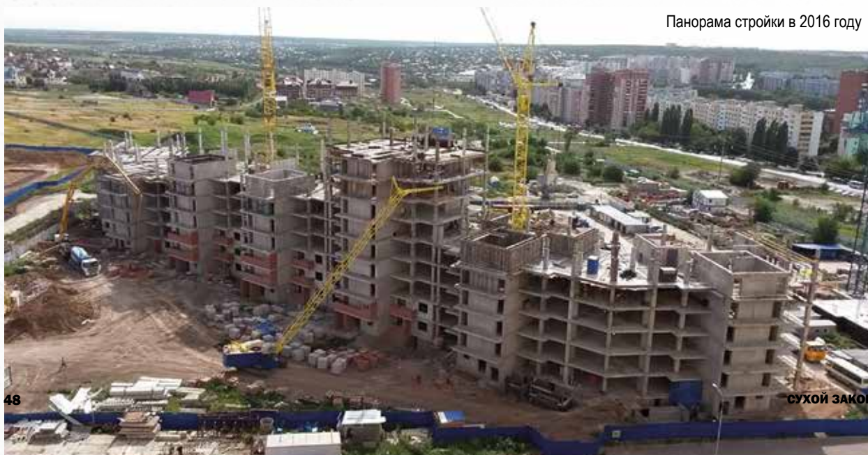
В подвальные помещения пришла вода
