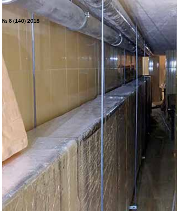
Внутренняя галерея. Стена слева – ограждающая. Протечек нет
