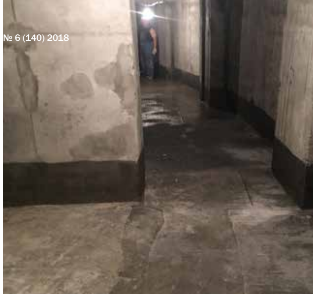
Обработка проникающим составом «Пенетрон»
