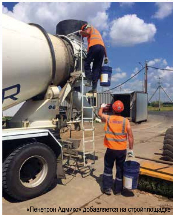
Бетонирование фундамента с «Пенетрон Адмикс»
