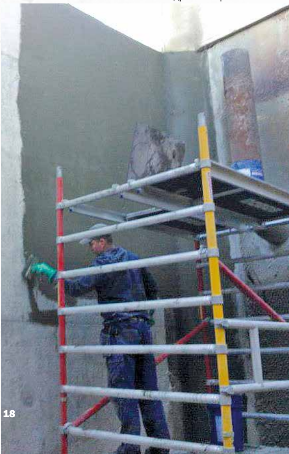
Гидроизоляция объектов сыроваренной компании «Выру Йуст»
